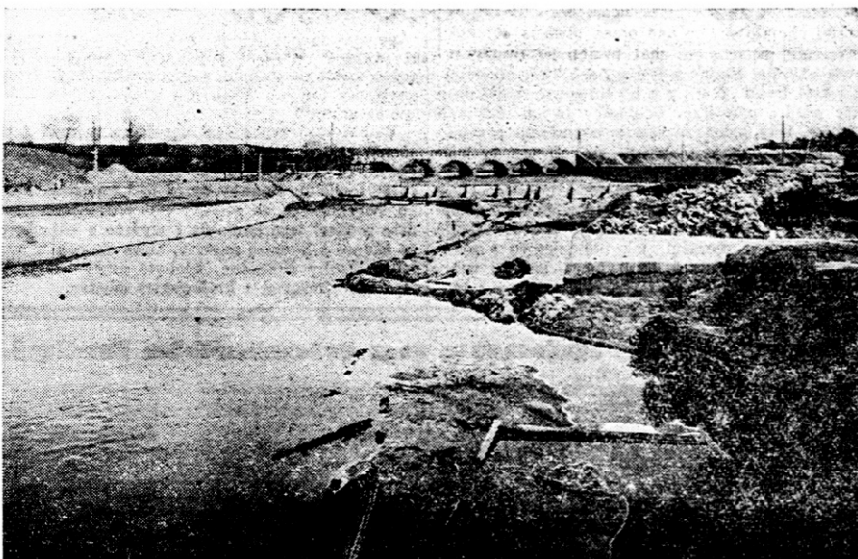
Rycina przedstawia widok na jaz żelazno-betonowy na rzece Białej Przemszy pod Maczkami, spiętrzający wodę dla państwowego wodociągu, przeznaczonego dla zaopatrywania w wodę Górnego Śląska i Zagłębia Dąbrowskiego, którego budowę rozpoczęto w połowie lipca 1929 r.
